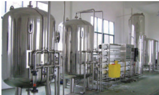
Мал. 116. Водоочисна станція, на якій річкову воду готують для подачі у мережу водогону
