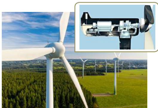
Мал. 5.6. У вітряках вітер обертає лопаті, і ця енергія одразу передається на електрогенератор
