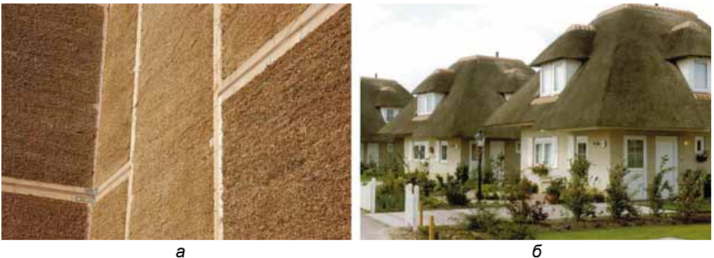
Мал. 149. Застосування природних матеріалів у будівництві житла: а – стіновий каркас із соломи; б – покрівля з очерету
